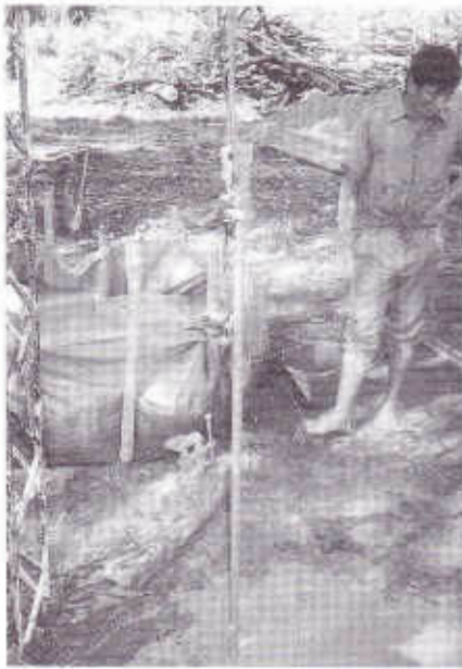
Bild 5. Bohrgestänge wird gezogen.
