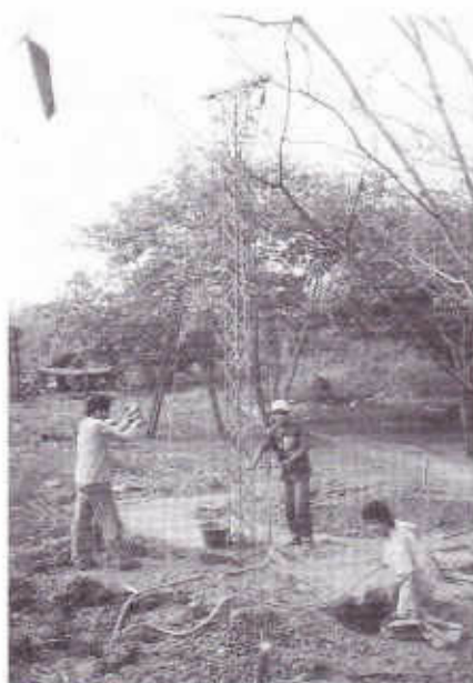
Bild 3. Brunnenbauer beim Bohren mit Bohrturm.
