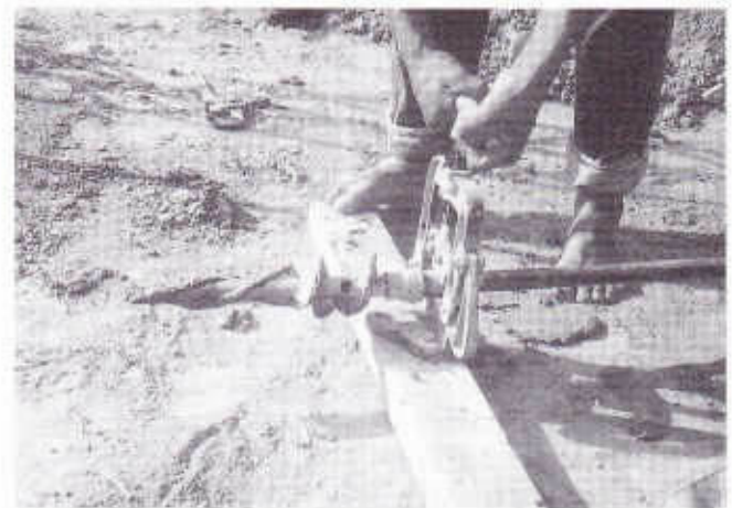
Bild 4. Bohrer und Bohrgestänge.
