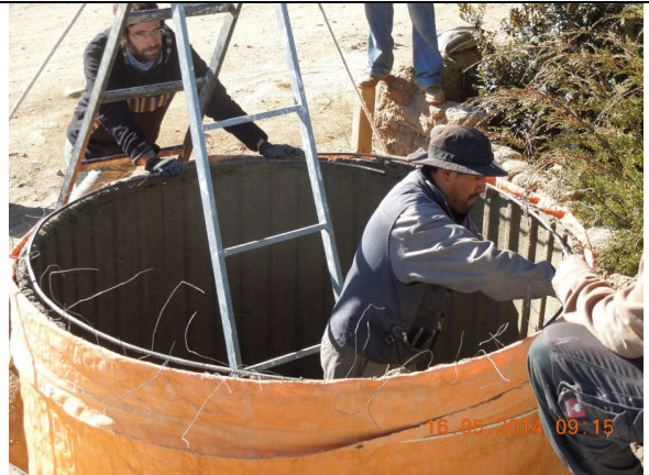
beim Bau des Ferrozement Tanks 6000 Liter
