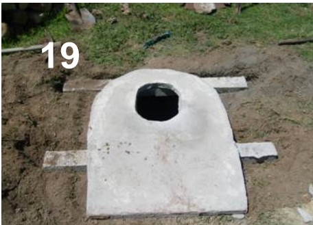
Abbildung 19, Bau eine geruchsarmen Trocken-Toilette
