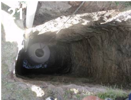
Abbildung 21, Verbesserter Schachtbrunnen
