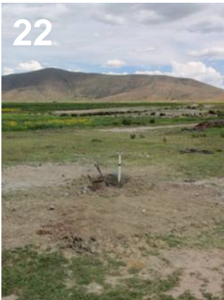
Abbildung 22, Fertiger verbesserter Schachtbrunnen
