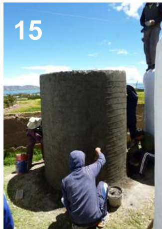
Abbildung 15, Bau überirdischer Zisterne
