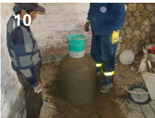
Abbildung 10, Bau eines Ferrozementtanks
