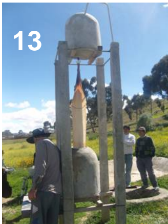
Abbildung 13, Ferrozementtank als Enteisungsfilter
