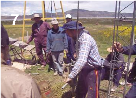
Abbildung 7, Saugbohren
