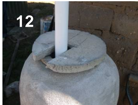
Abbildung 11, Ferrozementtank als Vorrattank der Dusche
