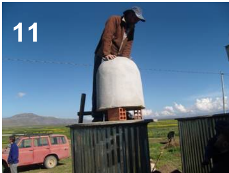
Abbildung 11, Ferrozementtank als Vorrattank der Dusche
