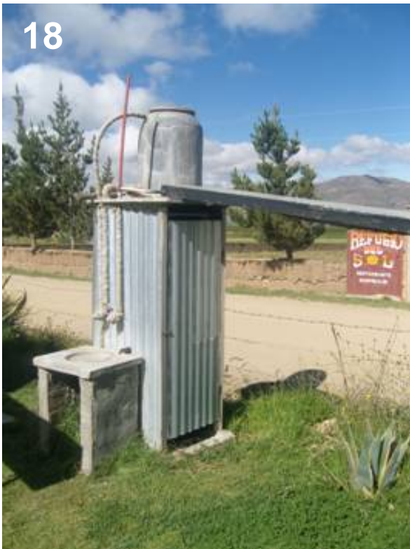
Abbildung 18, Dusche mit Sonnenkollektor
