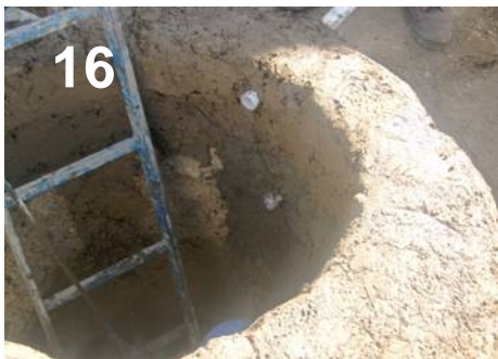
Abbildung 16, Bau unterirdischer Zisterne
