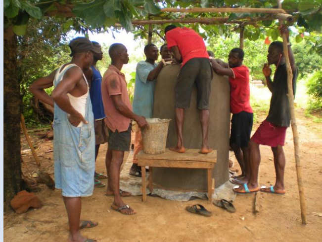
Kursteilnehmer lernen, wie man einen Tank aus Ferrozement baut
