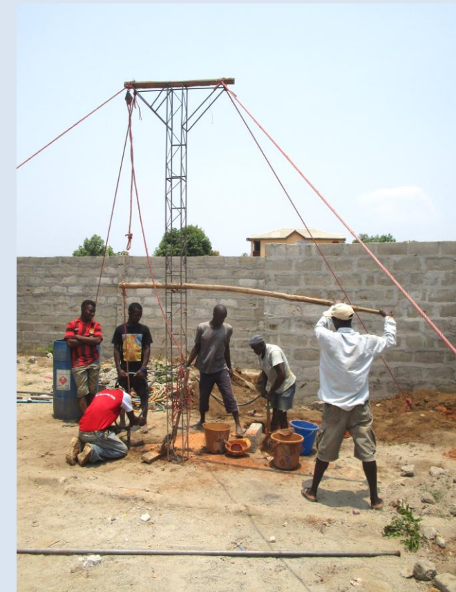
Teilnehmer eines Trainings lernen das Brunnenbohren. Drei Erwachsene können an einem Tag bis zu 40 m tief bohren
